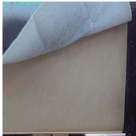
吹付面に裏写りせず、養生紙にも飛散なし
